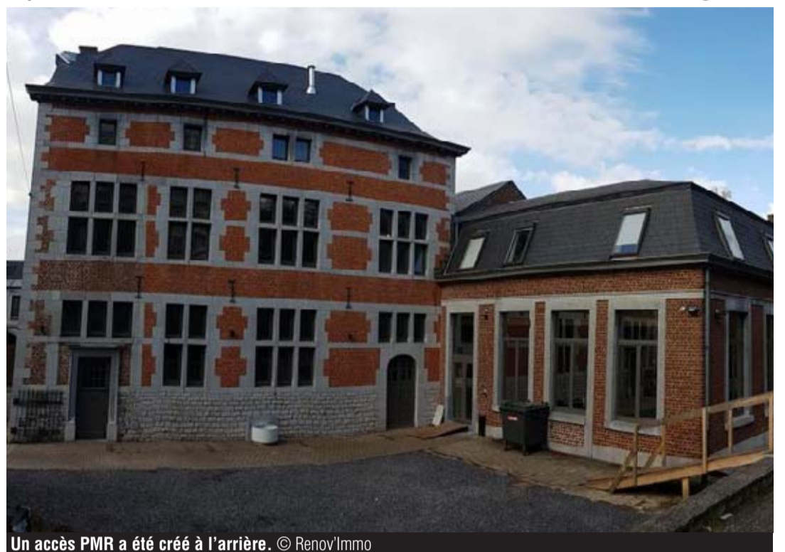
Un accès PMR a été créé à l'arrière. © Renov'Immo
